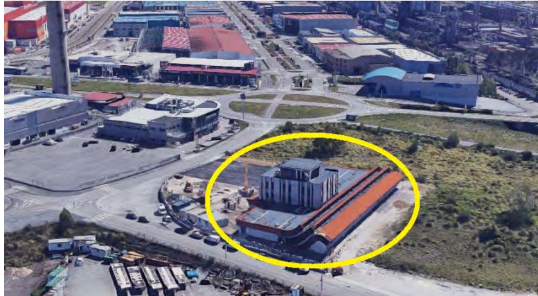
Vista aérea del edificio de la Escuela Superior de Arte
